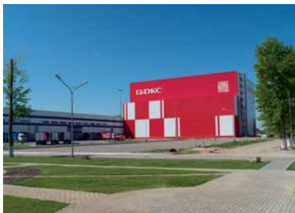
«ДКС» производит оборудование для электроснабжения предприятий в России и Европе
